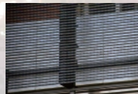
屏体外部无线化安装 no cables
